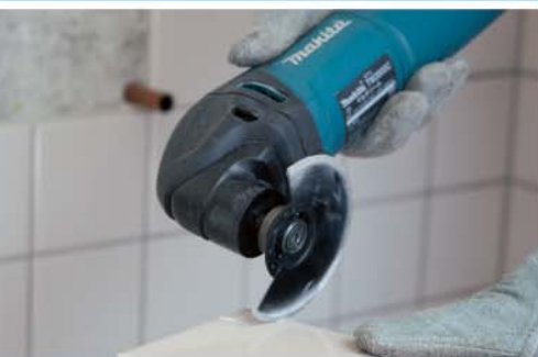
Резка керамической плитки
