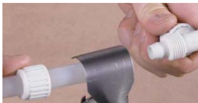
Монтаж пластиковых труб
