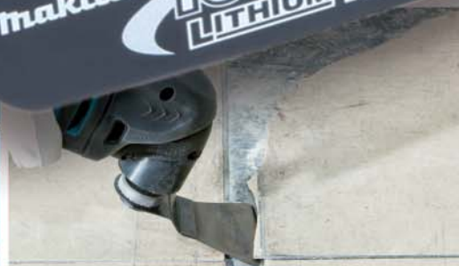
Удаление напольной плитки
