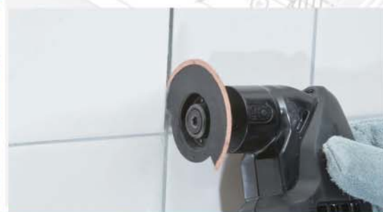
Очистка швов между плиткой
