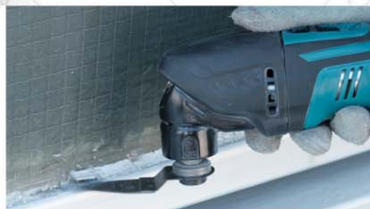
Удаление оконной замазки, герметика
