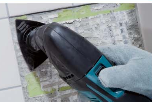
Удаление плиточного клея
